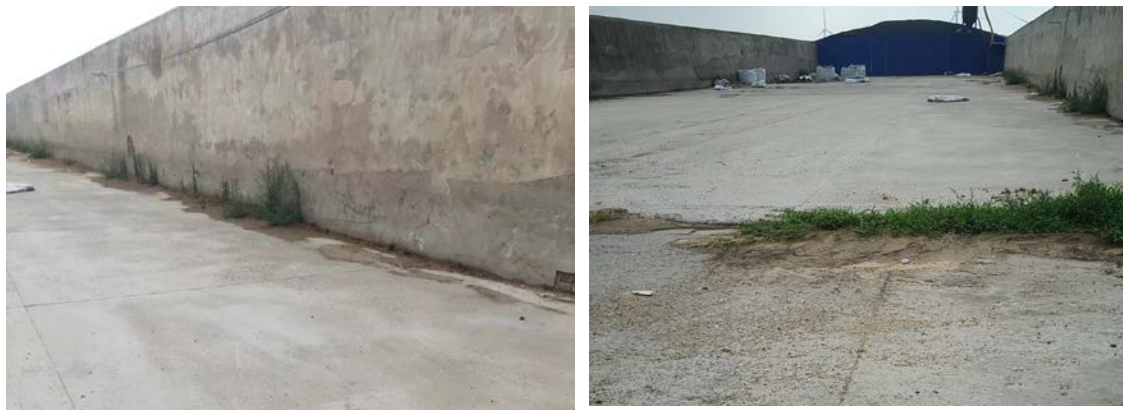
图 4-2 项目区地面硬化现状
