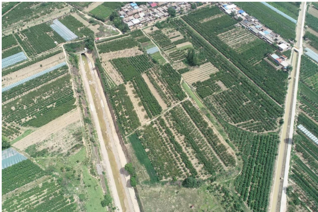
图2.9-2 引水闸、泥沙处理站及水厂现状图
