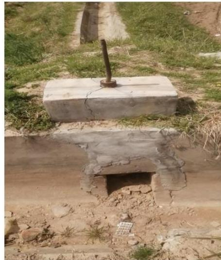
分水闸螺杆扭曲，发生破损
