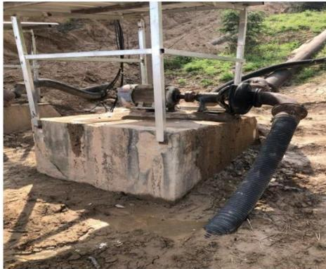
泵船坐滩后，水泵被移至固定点
