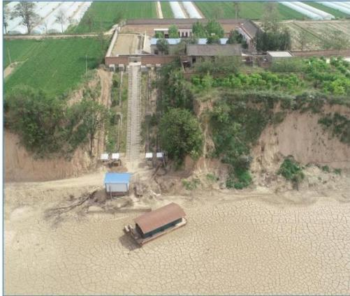
原泵站取水泵船已坐滩
