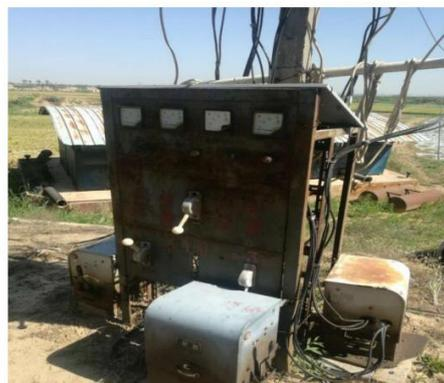
原水泵机组控制柜，露天，有漏电危险
