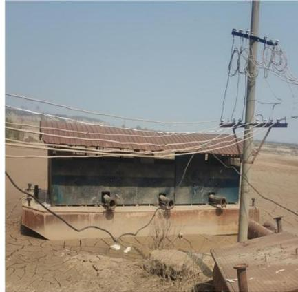
原泵站取水泵船已坐滩
